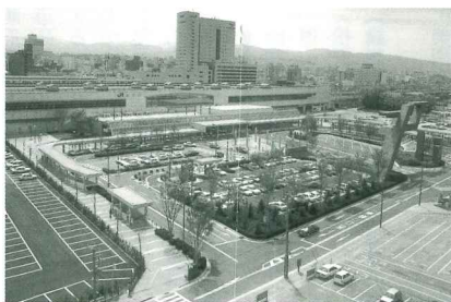
▲高架化された金沢駅と駅西広場の全景
