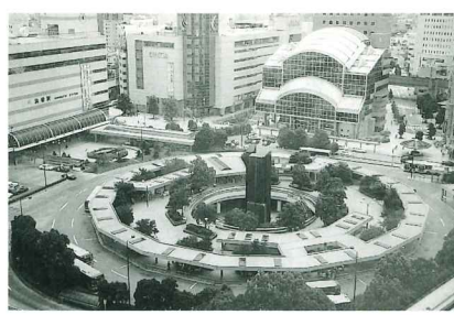
▲完成した浜松駅前広場
