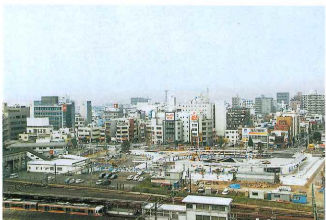
●整備が進む沼津駅北口駅前広場
