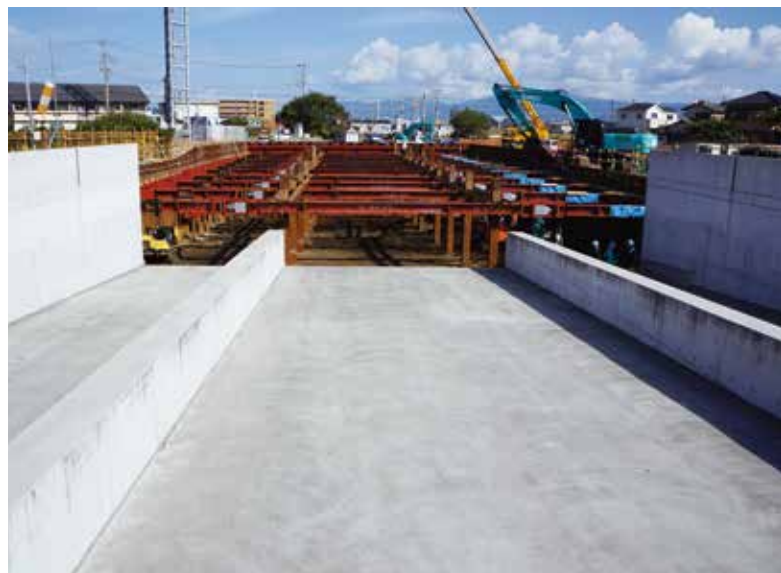
片浜西沢田線のアンダー構造物
