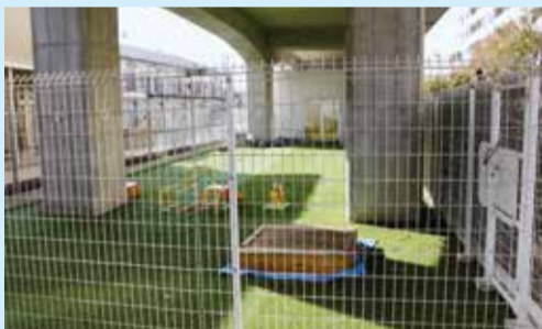
高架下に整備された園庭付きの保育所
