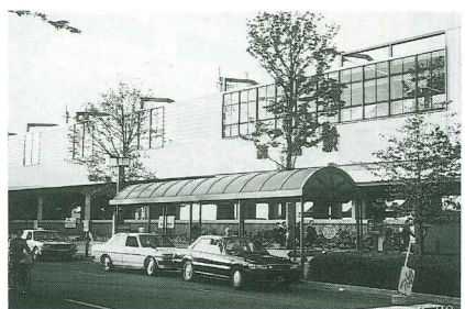
高架化が完成した前橋駅
