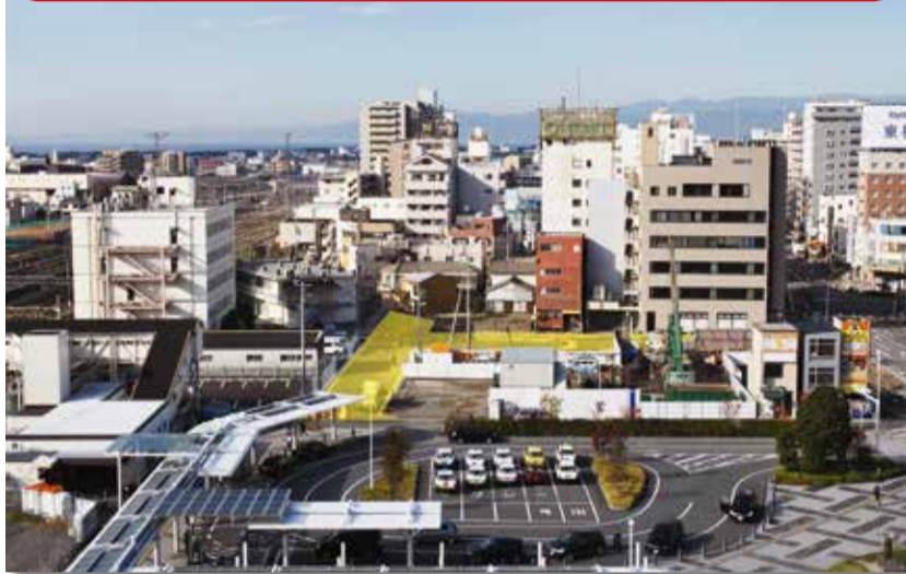
① 沼津駅北口駅前広場西側で工事が進んでいます
