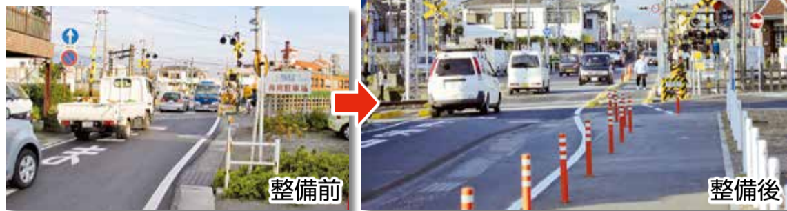
④ 高田踏切に2mの歩道が整備されました
