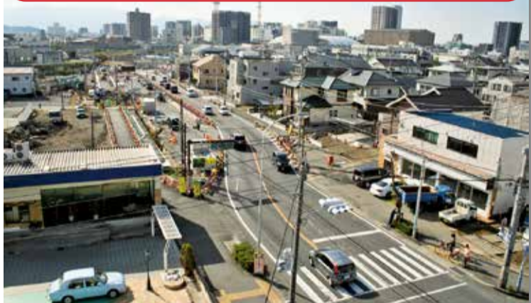
② ミツ目ガード北側で工事が進められています
